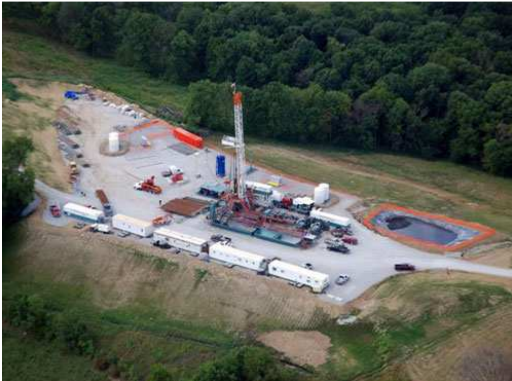
Les Wilson Drilling rig #30
